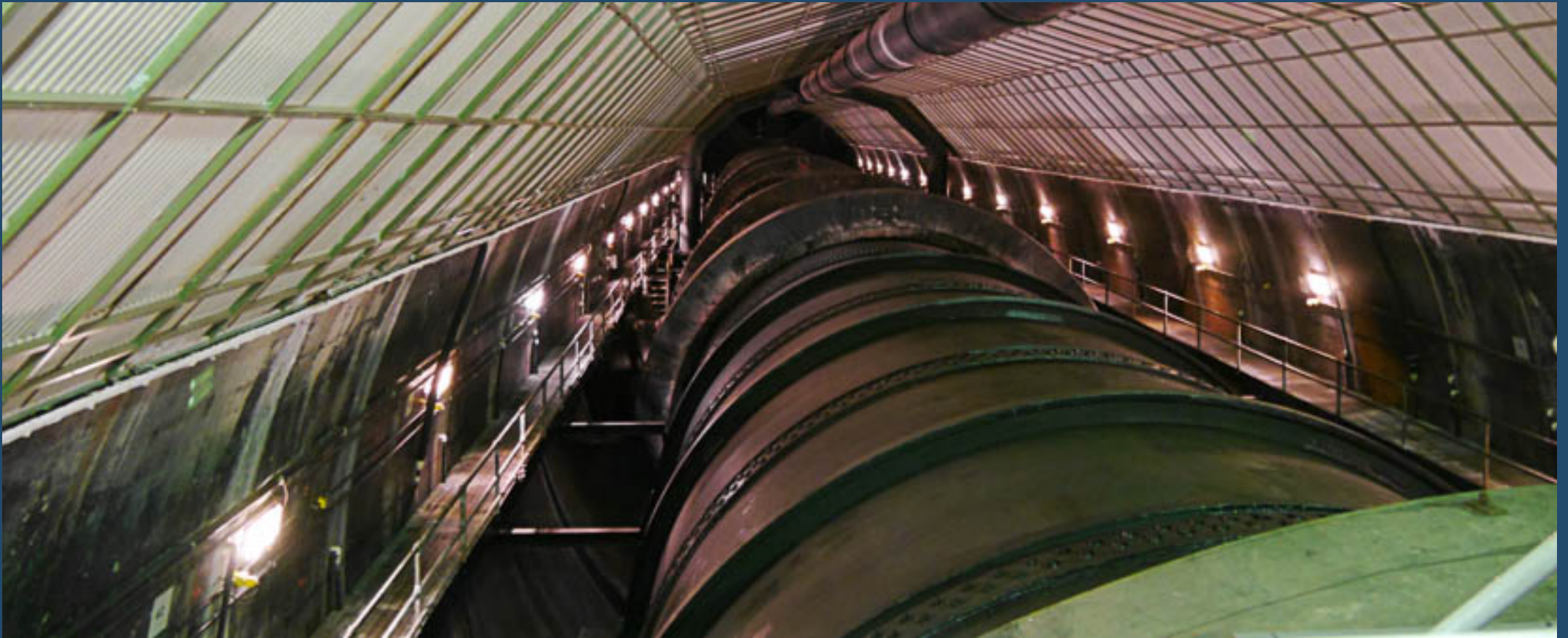
Durchmesser 5 m, da fließt das Wasser zu den Turbinen
