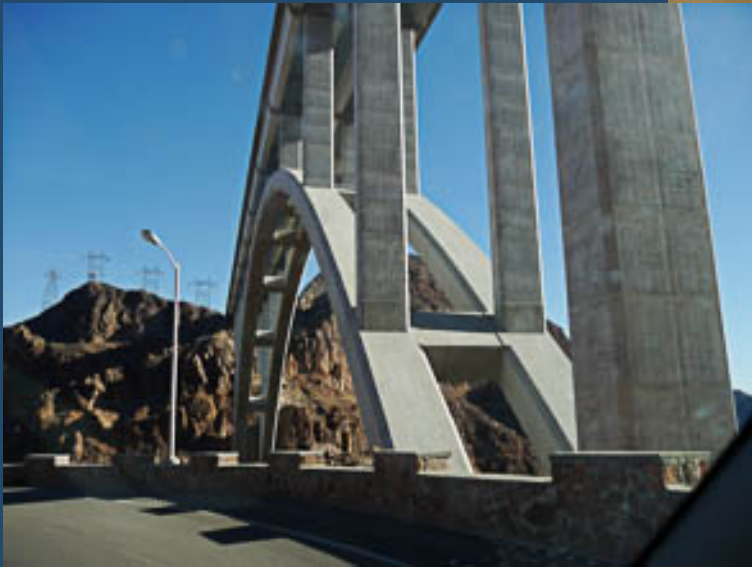
Unterhalb der neuen Brücke
