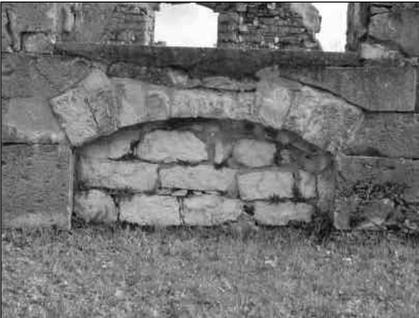
22 Ausmauerung aus Kalkbruchstein
